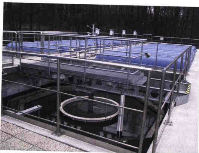
Obr. 1: ČOV Ostrava-Michálkovic, nitrifikační a denitrifikační nádrže jsou zastřešeny z důvodu zamezení zápachu
